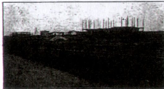
Fig. 2 - Vista generale dei lavori edificati del trasmettitore, abitazioni, cabine di trasmissione
