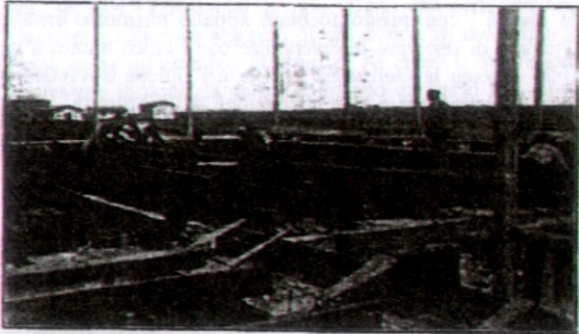
Fig. 1 - Edificio del trasmettitore - Copertura della grande Sala-macchine
